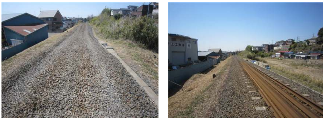
写真 1.5 那珂湊～殿山区間鉄道盛土の復旧状況
