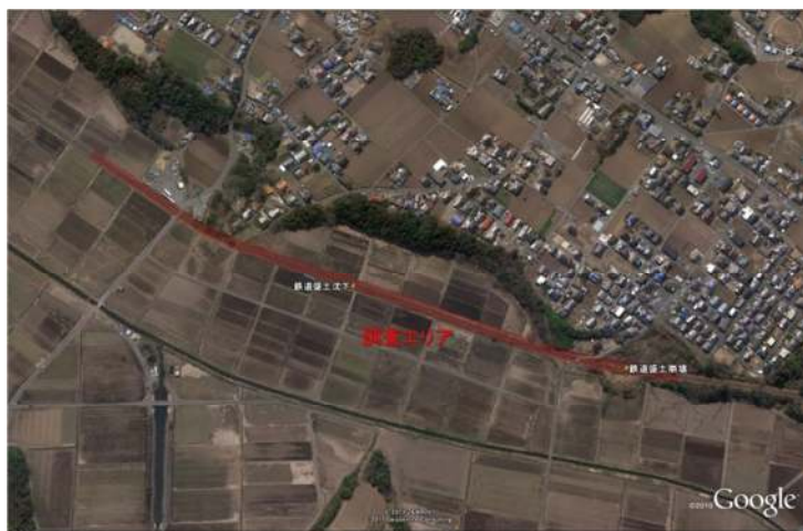
図 1.1 金上～中根区間の調査エリア
