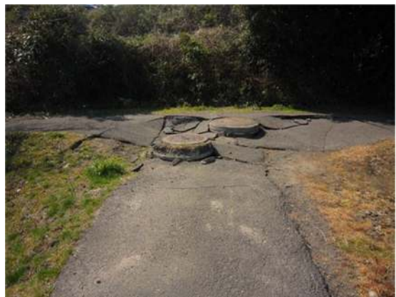
写真 1.1 金上～中根区間鉄道盛土の被災状況 現場の状況を YouTube でも公開しています。
