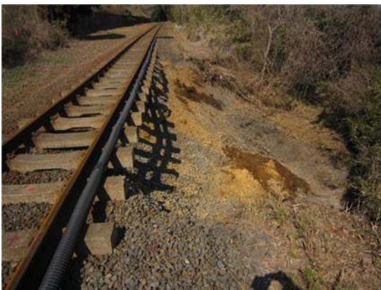
写真 1.1 金上～中根区間鉄道盛土の被災状況 現場の状況を YouTube でも公開しています。
