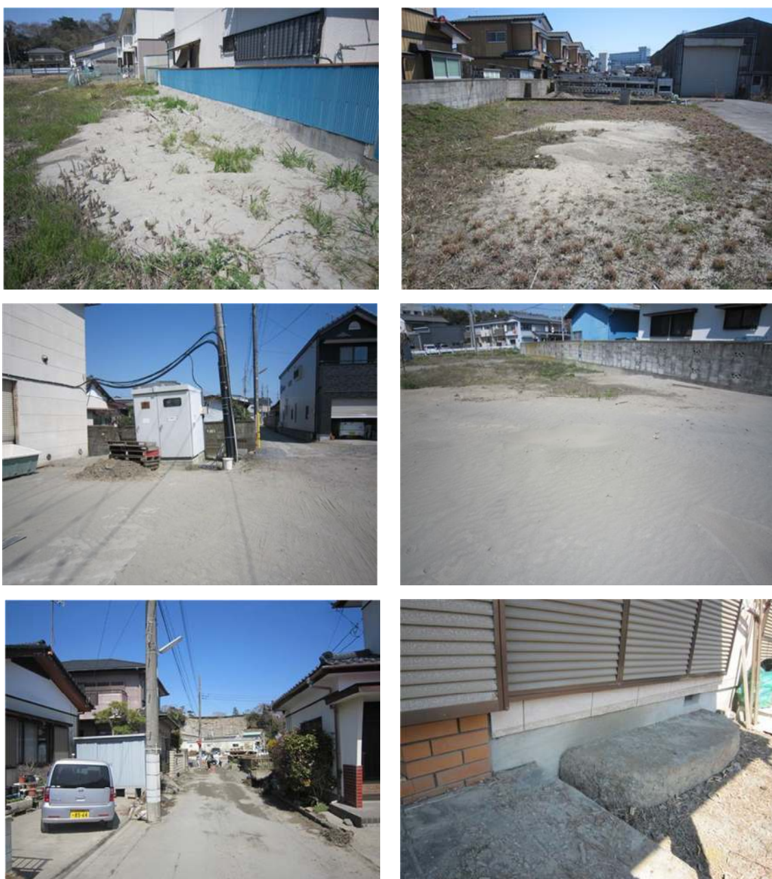
写真 3.1 海門地区の液状化被災状況（写真左下は 3/19 日撮影）
