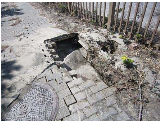
写真 阿字ヶ浦海岸 緩斜面の流動と被災状況
