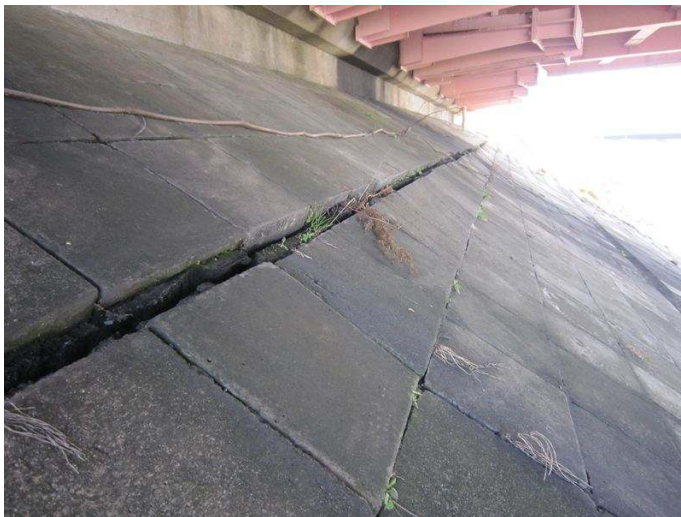
国道6号橋脚。橋脚基礎部の亀裂。
