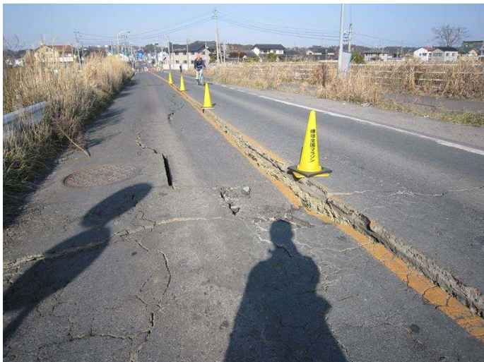
県道 351 号切土部斜面の陥没。
